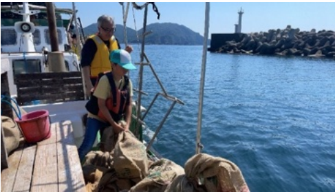
③藻場再生材海底設置
